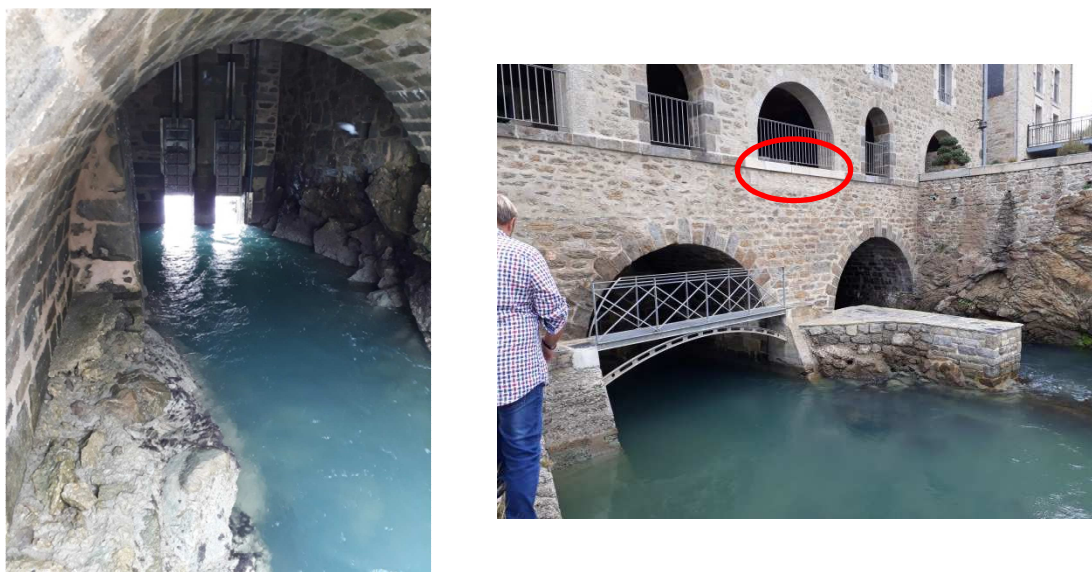
Figure 11 : Vannes et mur réhaussé du moulin de Roche-Goude
