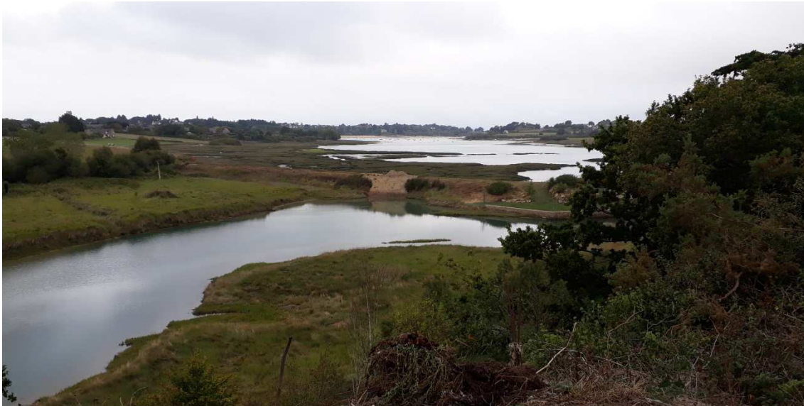
Figure 10 : Barrage de Roche-Goude
