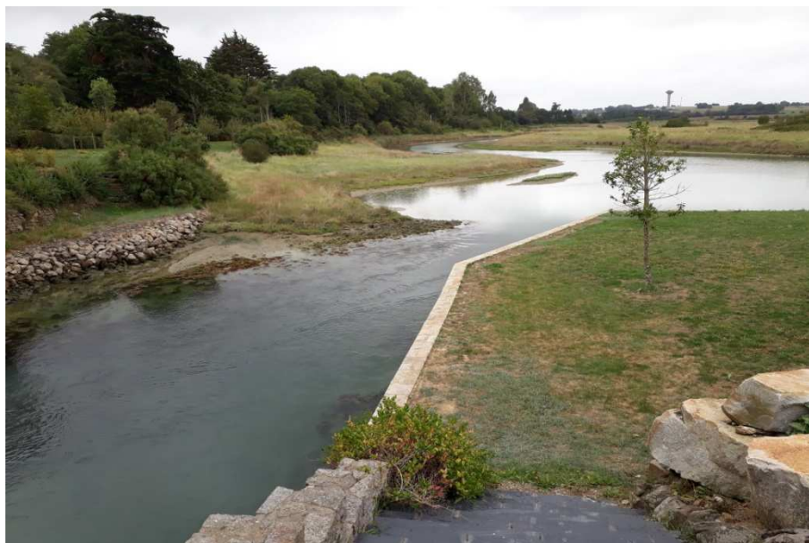
Figure 13 : Chemin préférentiel de l'eau en amont du moulin de Roche-Goude
