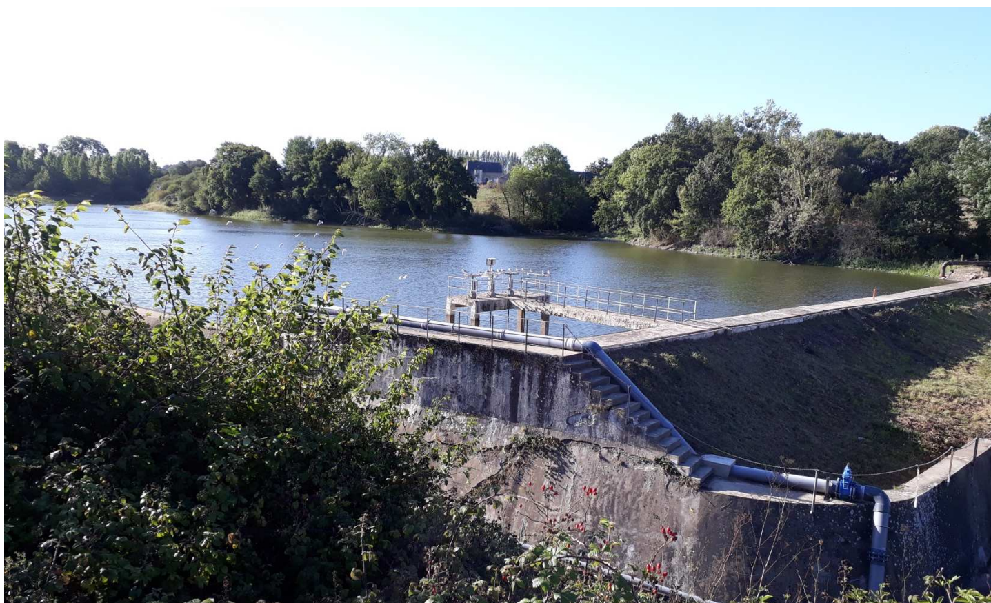
Le barrage de Pont-Avet sur le Frémur (CACG-Sept 2019)
