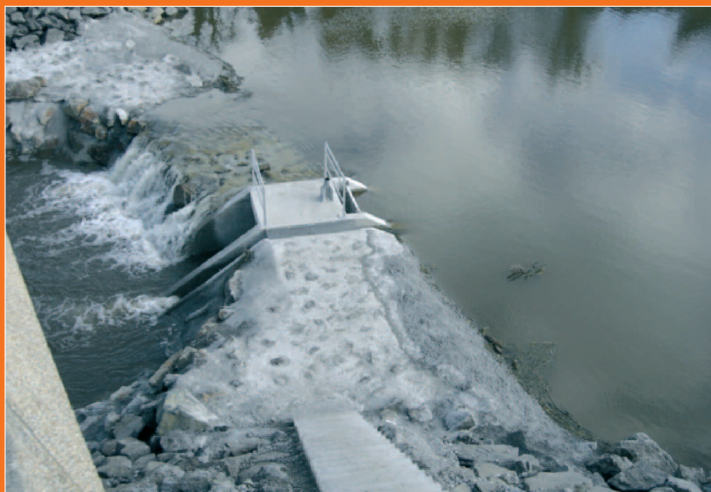
Pré-retenue du Pont des Rues, Ploubalay Décembre 2006
